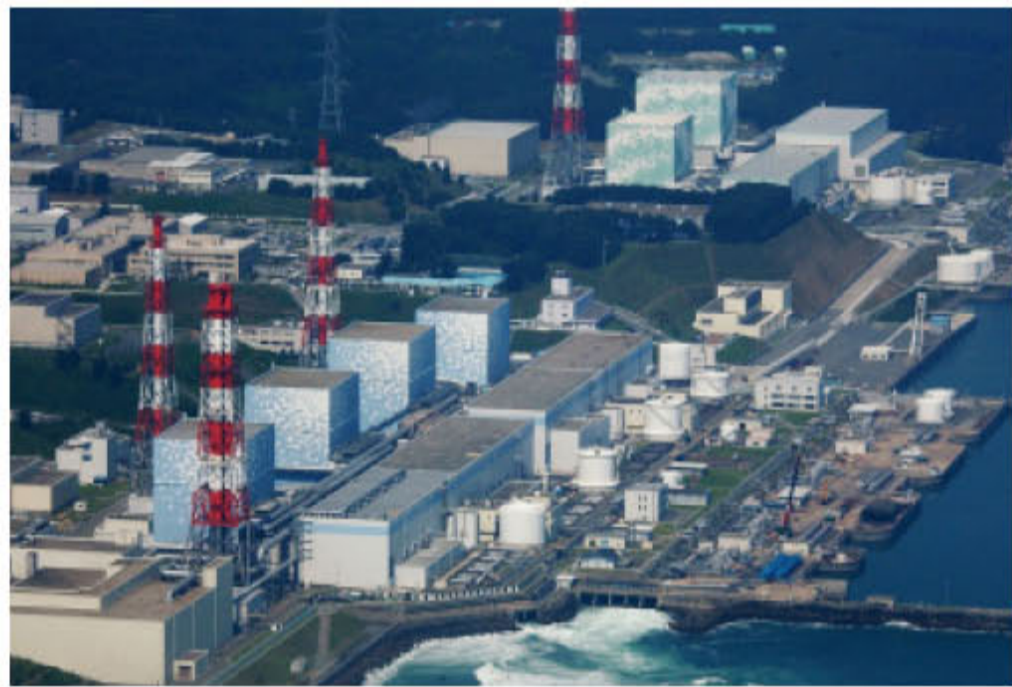
福島第一原子力発電所
